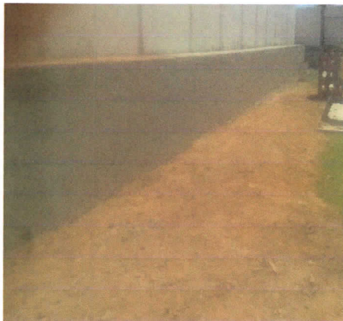
Figura 2 – Demolição da Cisterna
