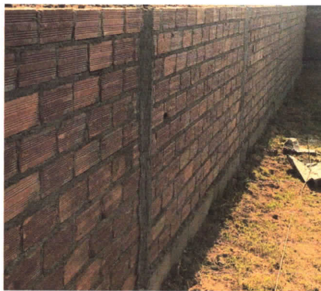
Figura 4 – Muro em Alvenaria
