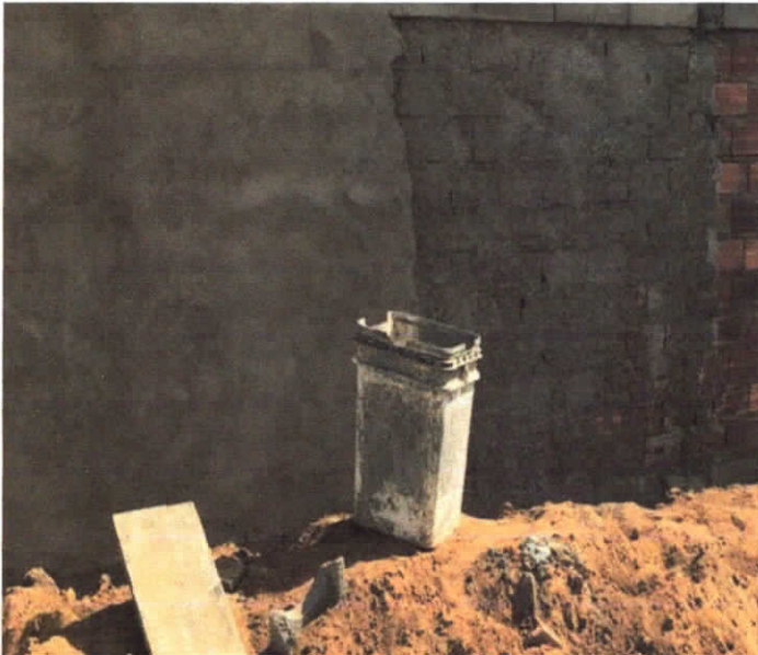
Figura 5 – Chapisco do Muro
