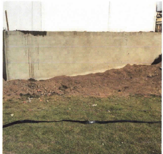
Figura 6 – Reboco do Muro
