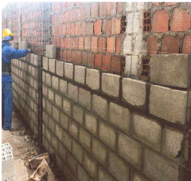
Figura 14 – Execução de Alvenaria de Blocos Cerâmicos
