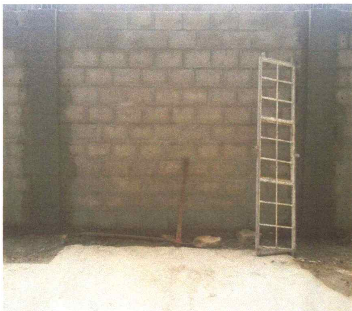
Figura 19 – Concretagem de Pilares
