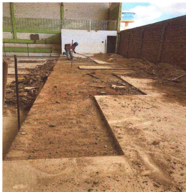
Figura 3 – Demolição de Piso Granilite
