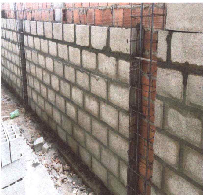
Figura 15 – Execução de Alvenaria de Blocos Cerâmicos
