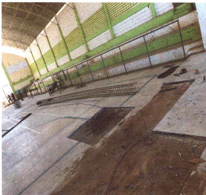
Figura 6 – Demolição de piso
