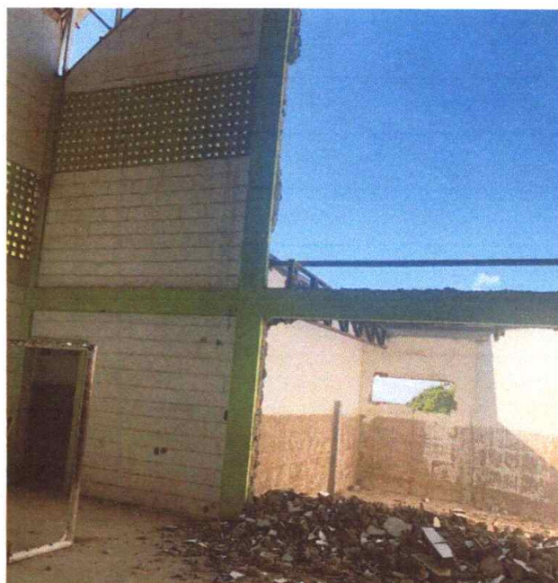
Figura 4 – Demolição de Alvenaria, Remoção de Esquadria
