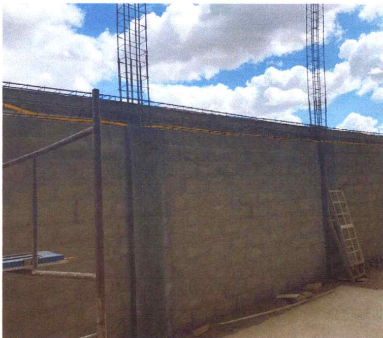
Figura 21 – Ferragem da Viga
