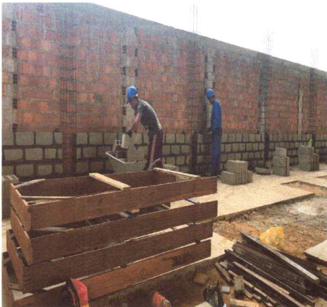
Figura 13 – Execução de Alvenaria de Blocos Cerâmicos
