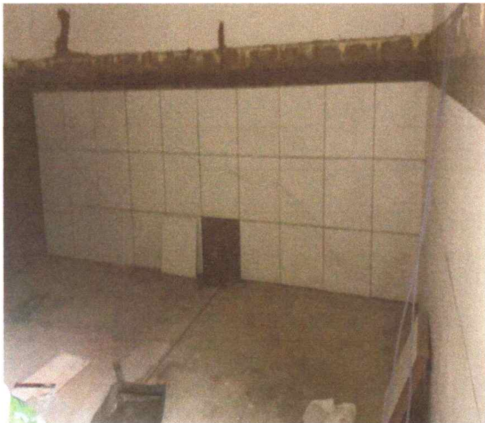
Figura 17 – Revestimento Cerâmico de Paredes
