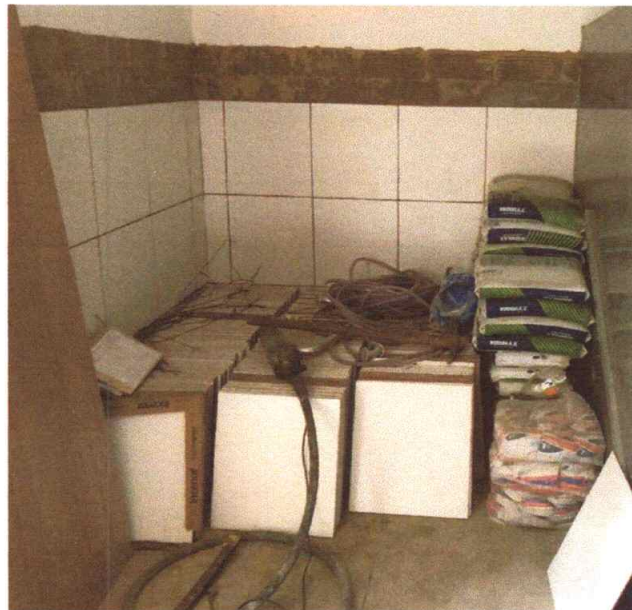
Figura 18 – Revestimento Cerâmico de Paredes
