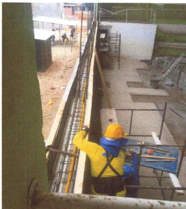
Figura 22 – Fôrma e Ferragem da Viga
