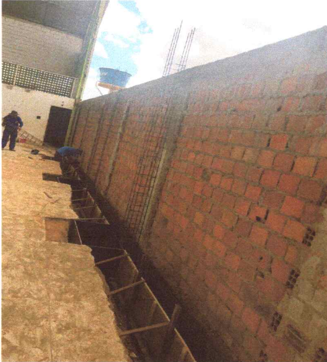
Figura 9 – Fôrma e Ferragem de Blocos, Baldrames e Pilares
