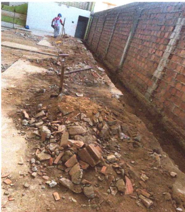
Figura 5 – Demolição de pilares, vigas e baldrame
