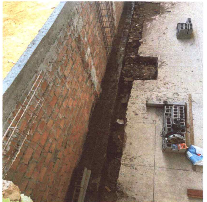
Figura 12 – Concretagem da Fundação concluída
