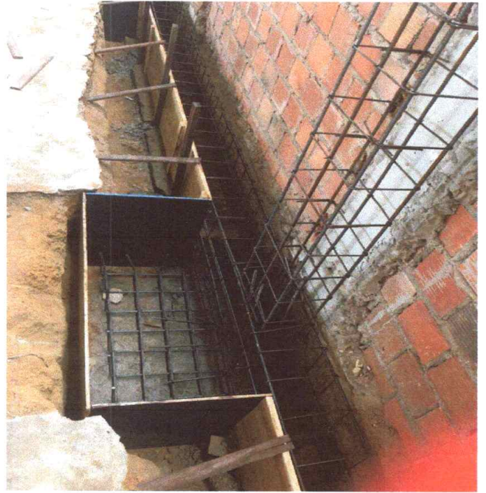
Figura 10 – Fôrma e Ferragem de Blocos, Baldrames e Pilares
