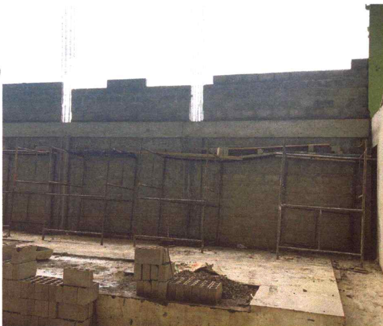
Figura 23 – Concretagem da Viga Concluída e Execução de Alvenaria
