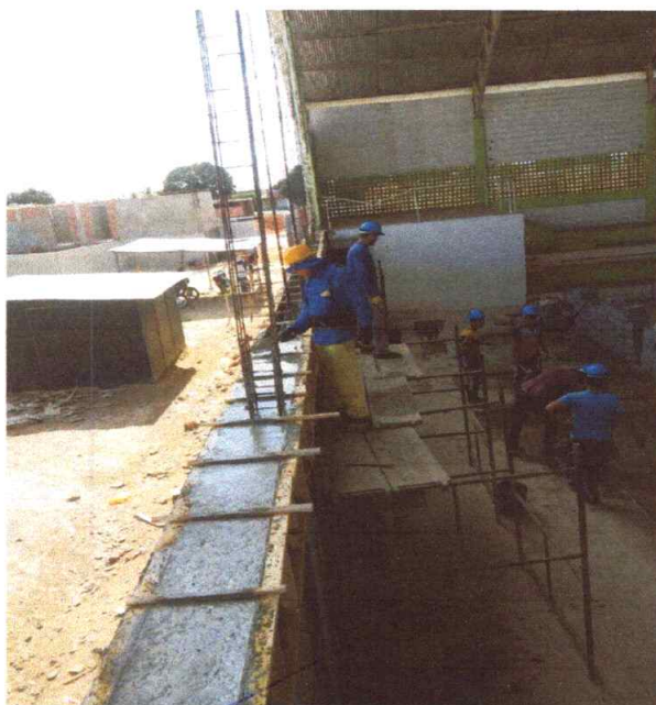
Figura 24 – Concretagem da Viga Concluída
