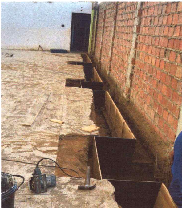
Figura 7 – Fôrma de Blocos e Baldrames
