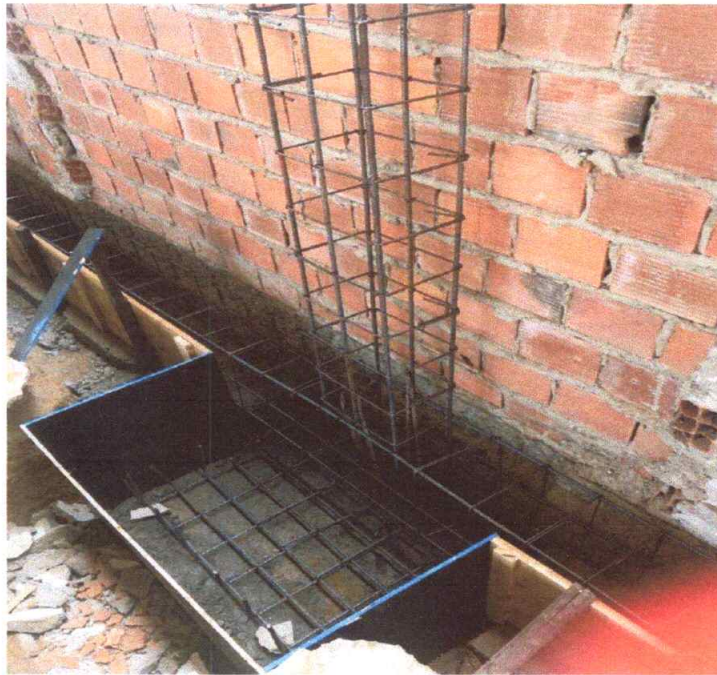
Figura 8 – Ferragem de Blocos e Baldrames
