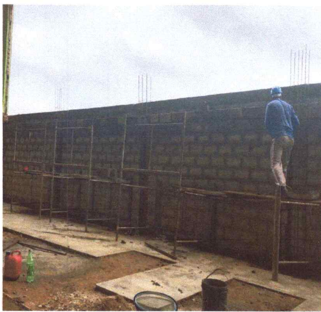
Figura 16 – Execução de Alvenaria de Blocos Cerâmicos
