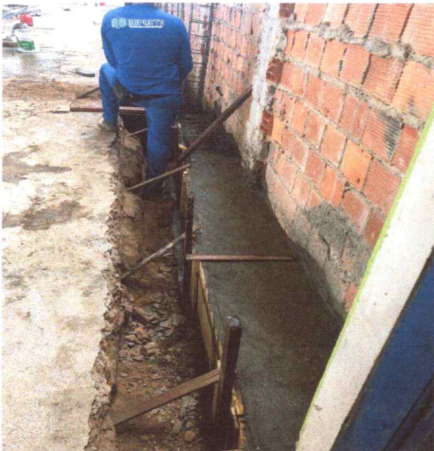
Figura 11 – Concretagem de Blocos e Baldrames
