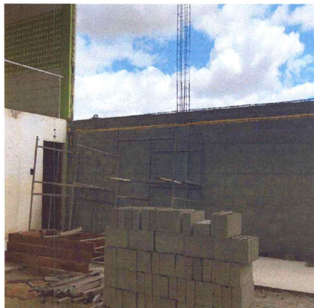
Figura 20 – Ferragem da Viga
