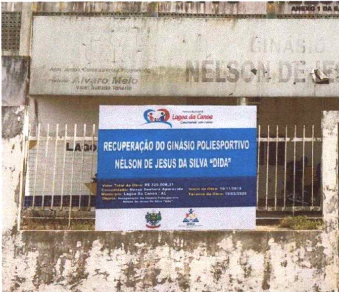
Figura 1 – Placa de Obra
