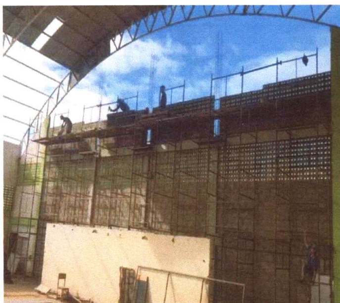
Figura 11 – Execução de Cobogós
