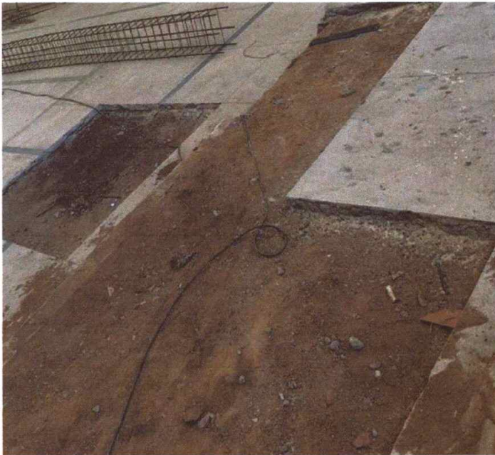
Figura 5 – Demolição de Piso
