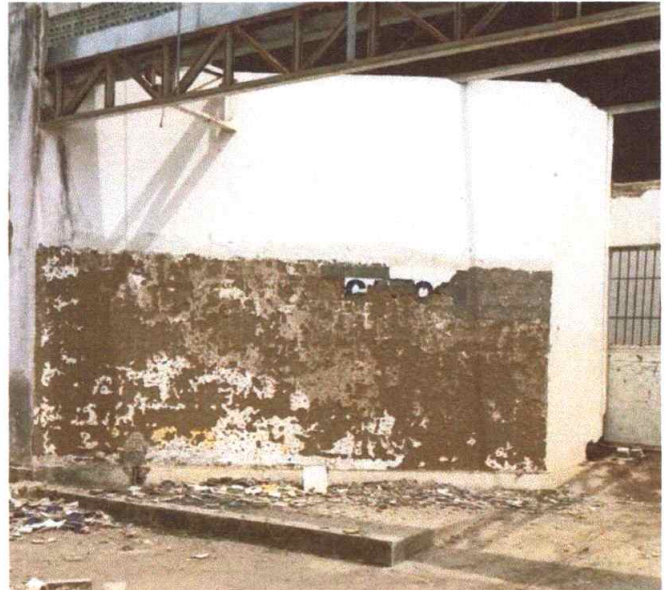
Figura 2 – Demolição de Revestimento Cerâmico
