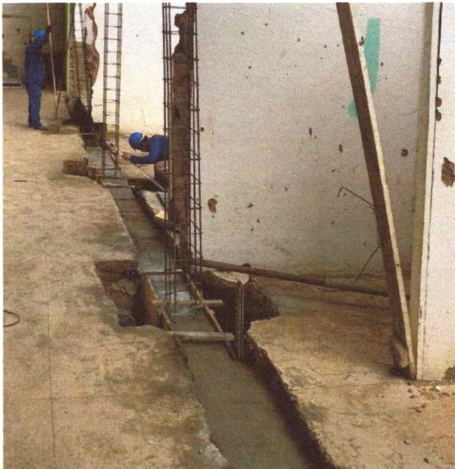
Figura 15 – Execução de Viga Baldrame
