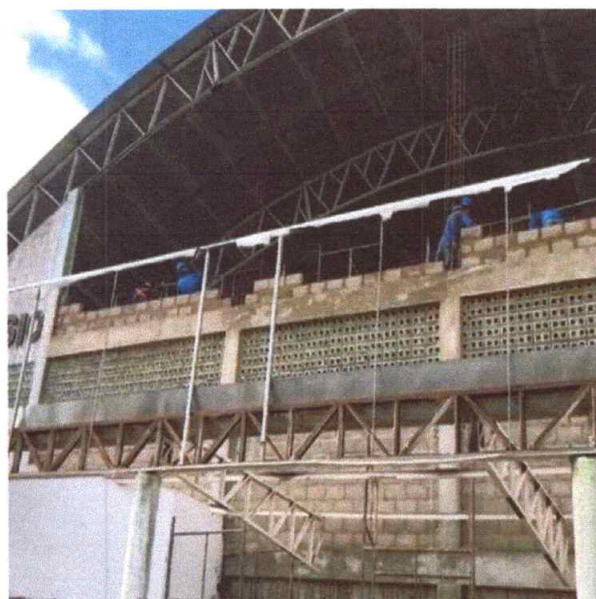
Figura 12 – Execução de Cobogós
