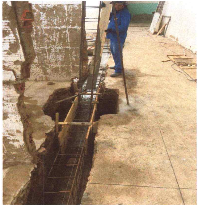
Figura 16 – Execução de Viga Baldrame
