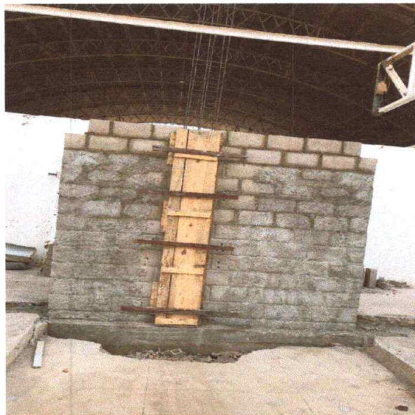
Figura 10 – Execução de Alvenaria
