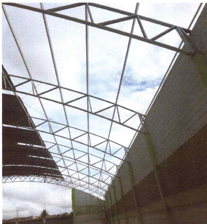
Figura 23 – Pintura da Estrutura Metálica
