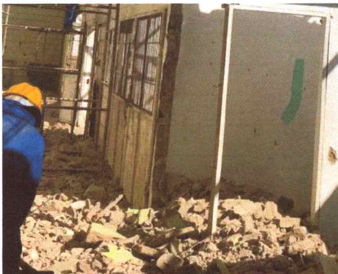
Figura 3 – Demolição de Alvenaria
