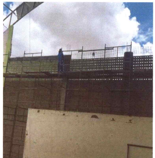
Figura 20 – Execução de Vigas
