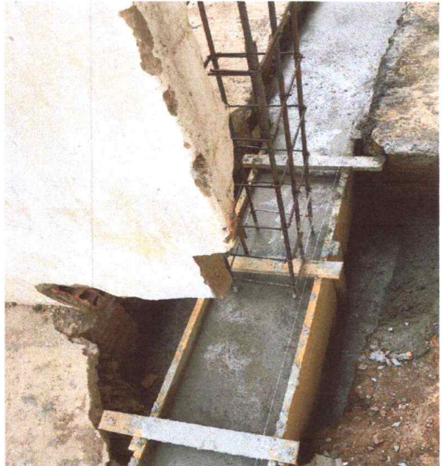
Figura 14 – Execução de Sapatas
