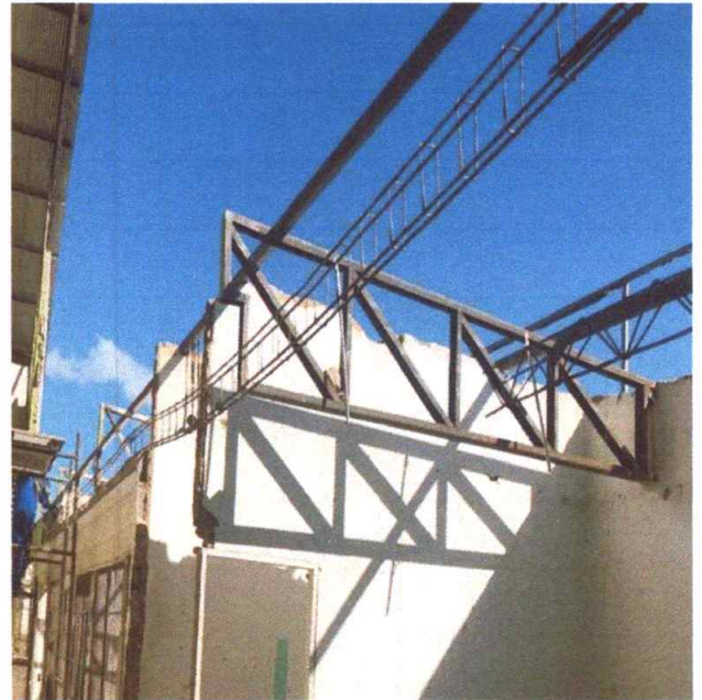
Figura 6 – Demolição de Ferragens
