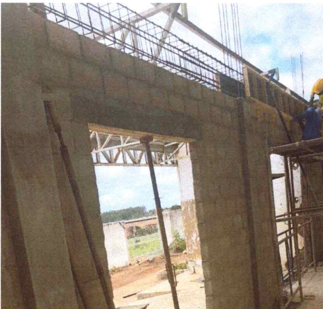
Figura 19 – Execução de Vigas
