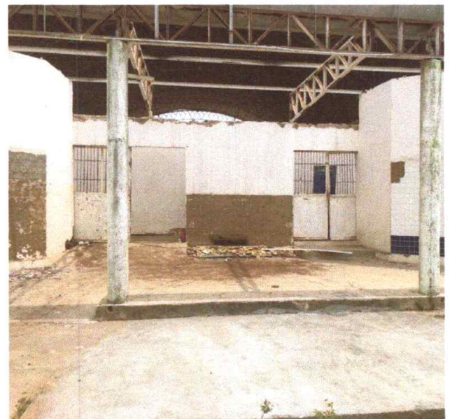
Figura 8 – Remoção de Telhas
