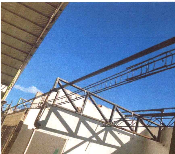
Figura 7 – Demolição de Ferragens
