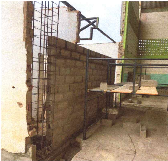
Figura 17 – Execução de Pilares
