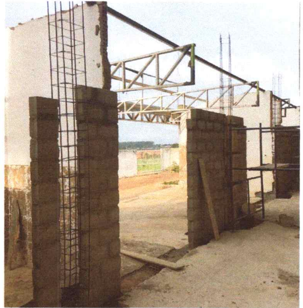
Figura 18 – Execução de Pilares
