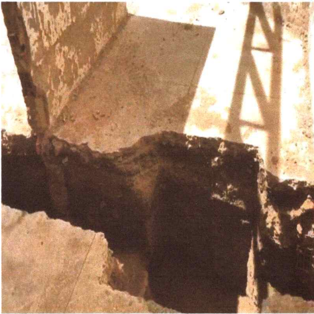
Figura 13 – Escavação de Valas
