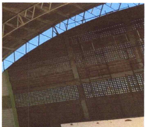
Figura 4 – Execução de Alvenaria de Blocos Cerâmicos
