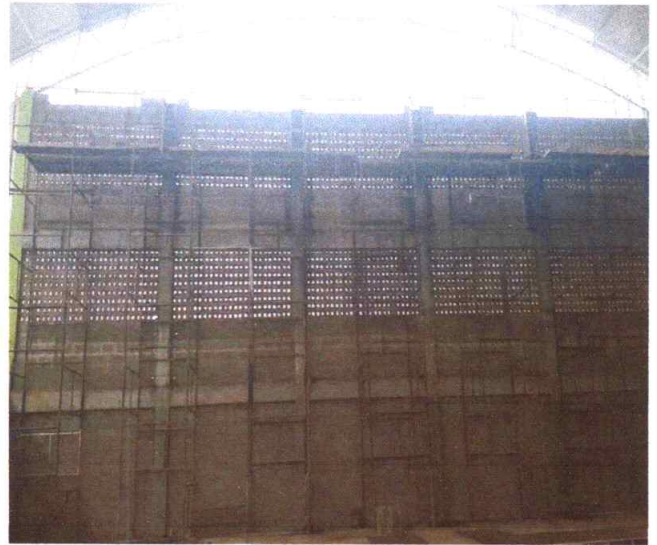
Figura 6 – Execução de Alvenaria de Cobogós
