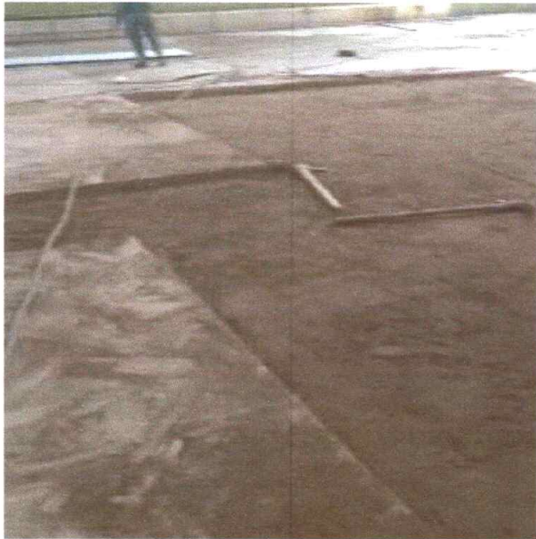
Figura 1 – Demolição de Piso
