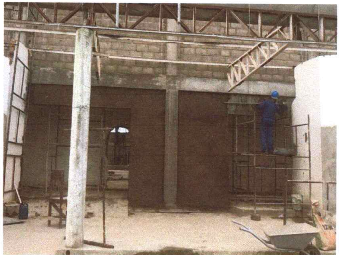
Figura 14 – Reboco/Emboço
