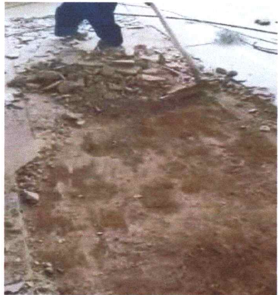
Figura 2 – Demolição de Piso
