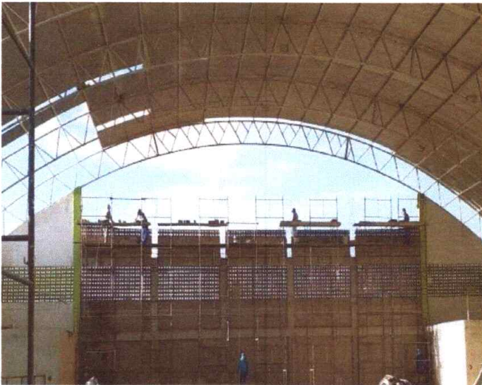
Figura 5 – Execução de Alvenaria de Cobogós
