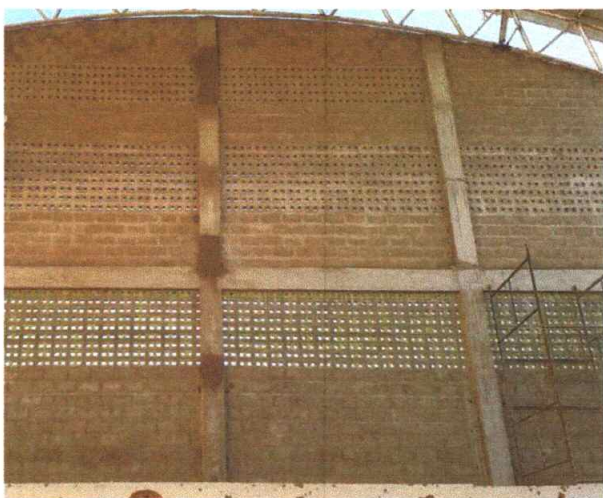
Figura 3 – Execução de Alvenaria de Blocos Cerâmicos
