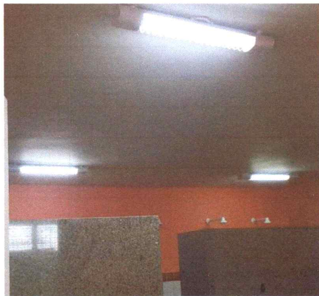
Figura 12 – Pintura de Teto
