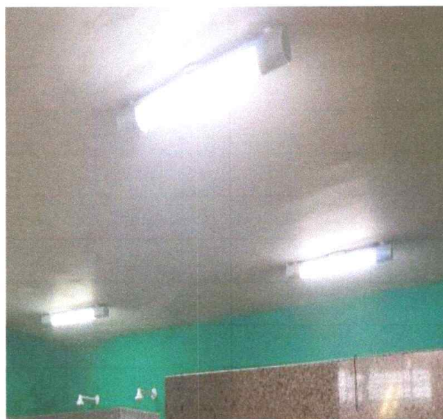
Figura 11 – Pintura de Teto
