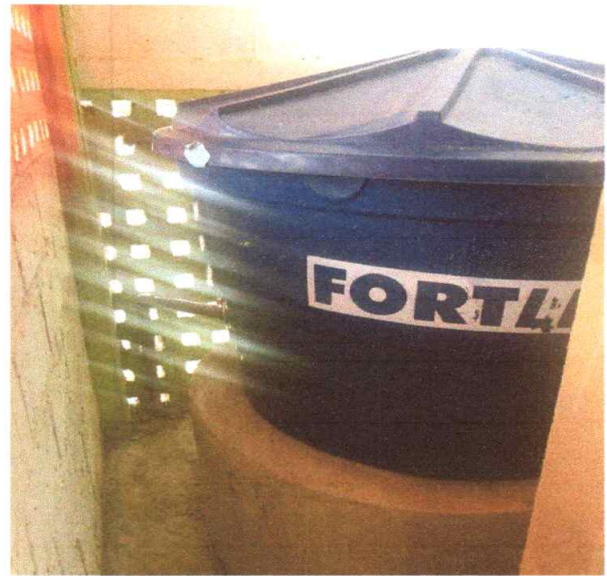
Figura 6 – Instalação da Caixa D'água
