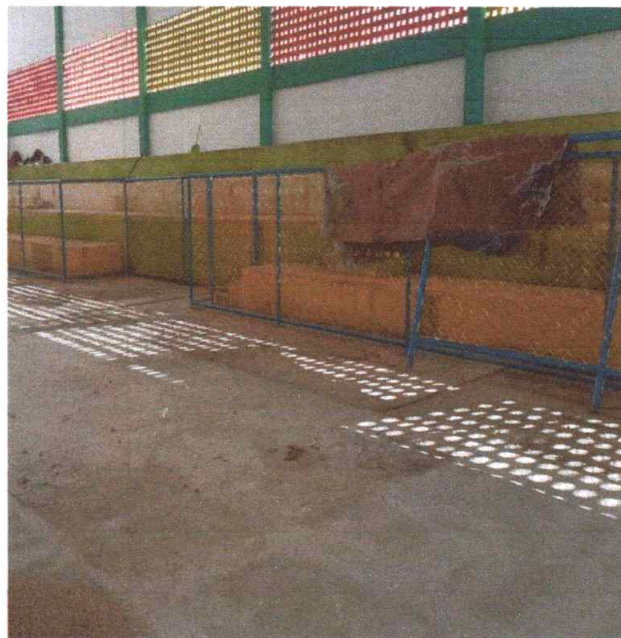
Figura 14 – Pintura de Estruturas Metálicas
