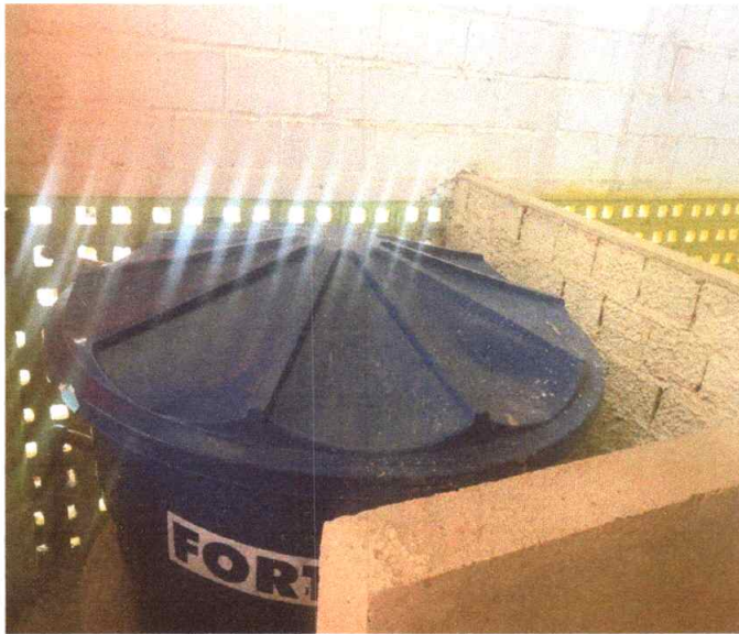
Figura 5 – Instalação da Caixa D'água
