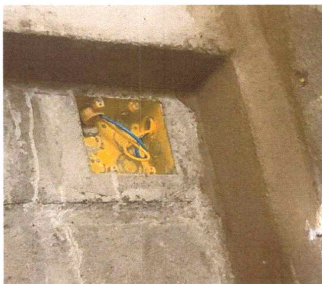
Figura 9 – Quadro de Distribuição
