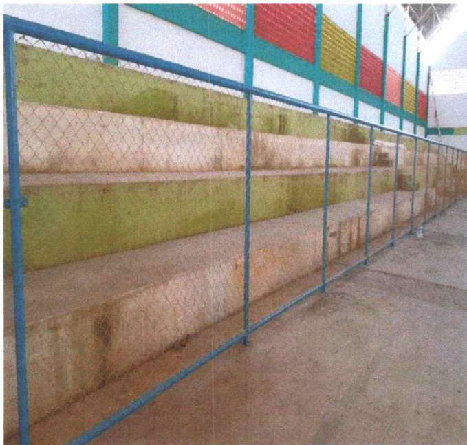
Figura 13 – Pintura de Estruturas Metálicas
