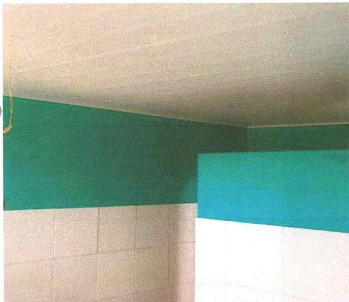
Figura 13 – Instalação de PVC
