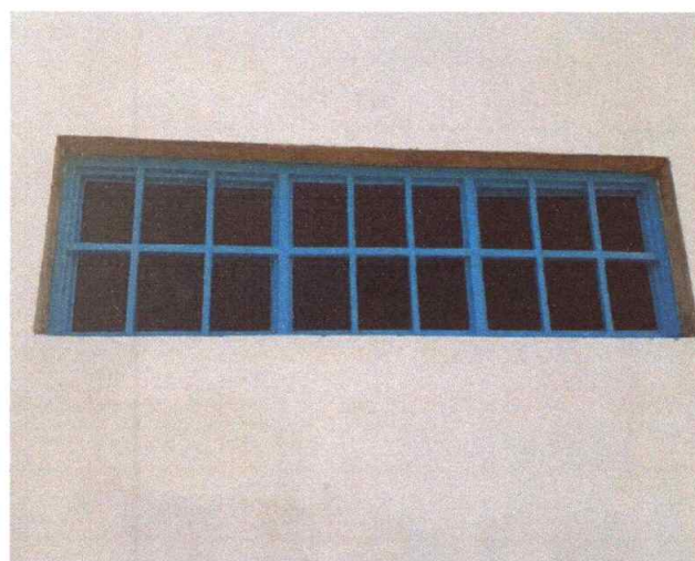
Figura 20 – Pintura de Esquadrias
