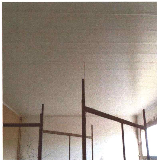
Figura 16 – Instalação de PVC
