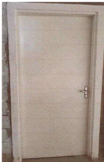
Figura 18 – Pintura de Esquadrias
