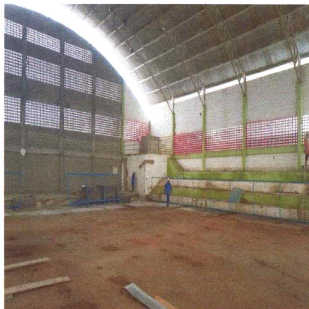
Figura 2 – Demolição do Piso
