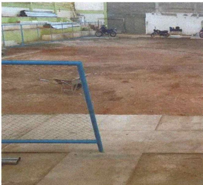
Figura 1 – Demolição do Piso
