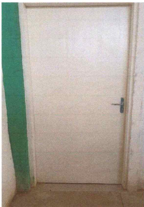
Figura 17 – Pintura de Esquadrias
