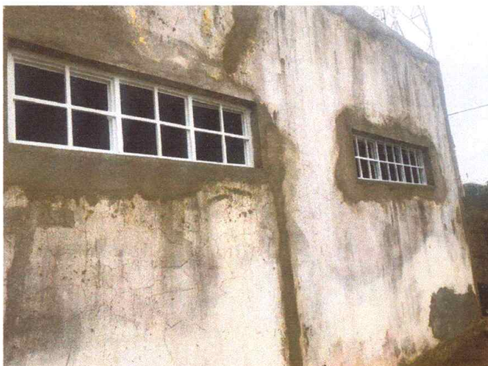
Figura 7 – Instalação de Janelas
