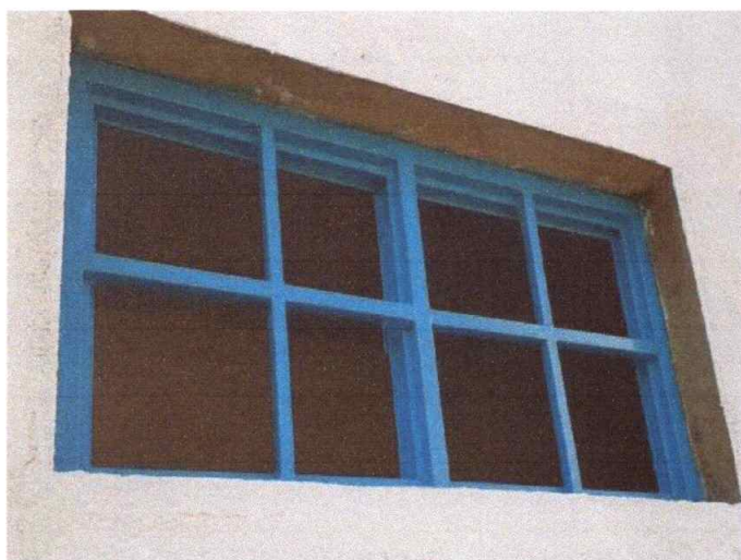
Figura 19 – Pintura de Esquadrias
