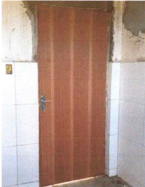
Figura 5 – Instalação de Portas
