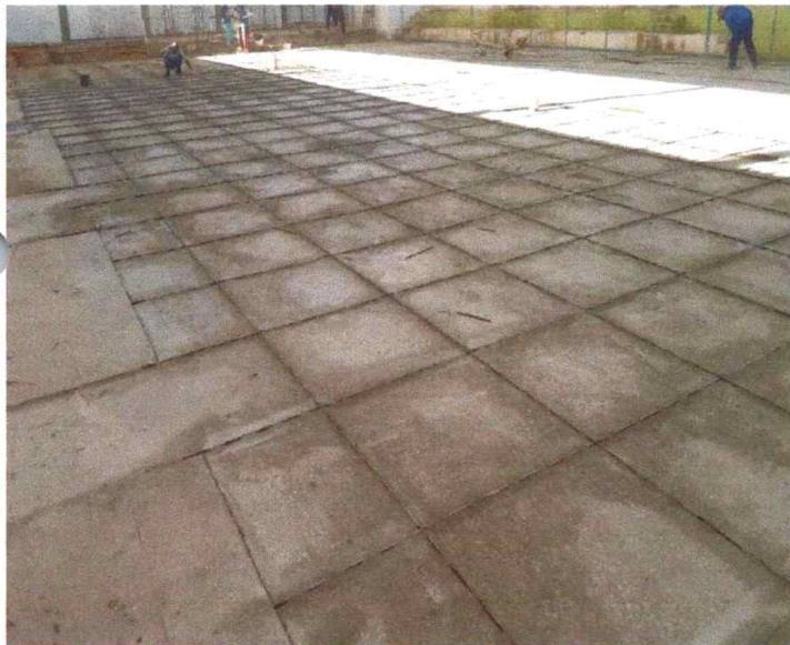
Figura 9 – Execução do Piso Granilite
