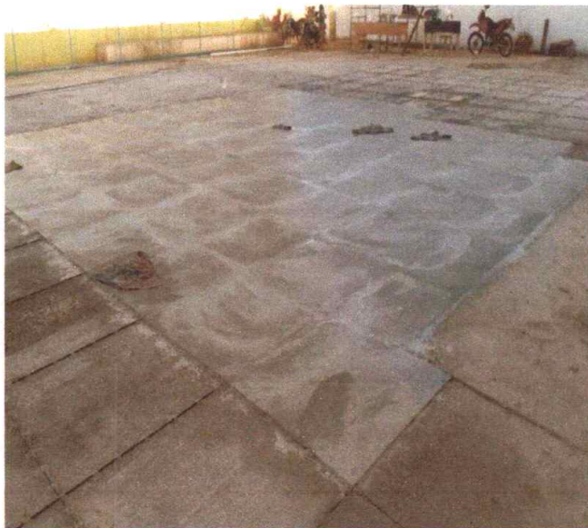
Figura 10 – Execução do Piso Granilite
