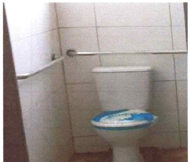
Figura 20 – Barras de Apoio
