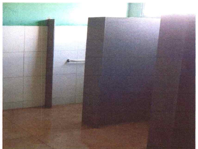
Figura 4 – Divisória de Granito
