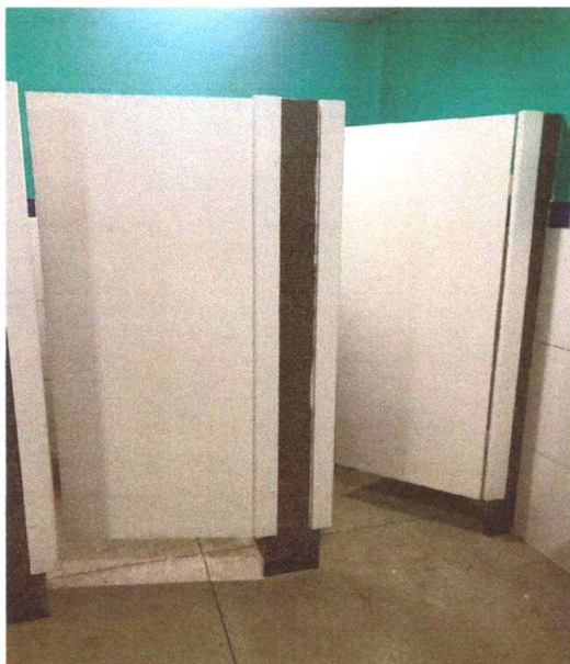
Figura 15 – Portas dos Banheiros
