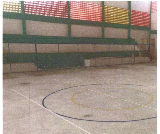
Figura 6 – Pintura de Paredes
