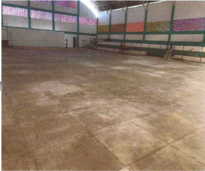
Figura 1 – Piso Granilite Concluído
