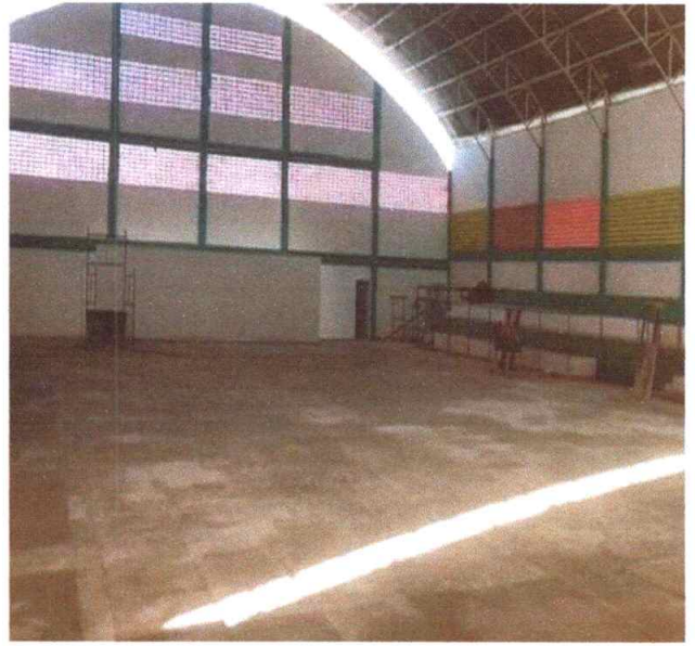
Figura 2 – Piso Granilite Concluído
