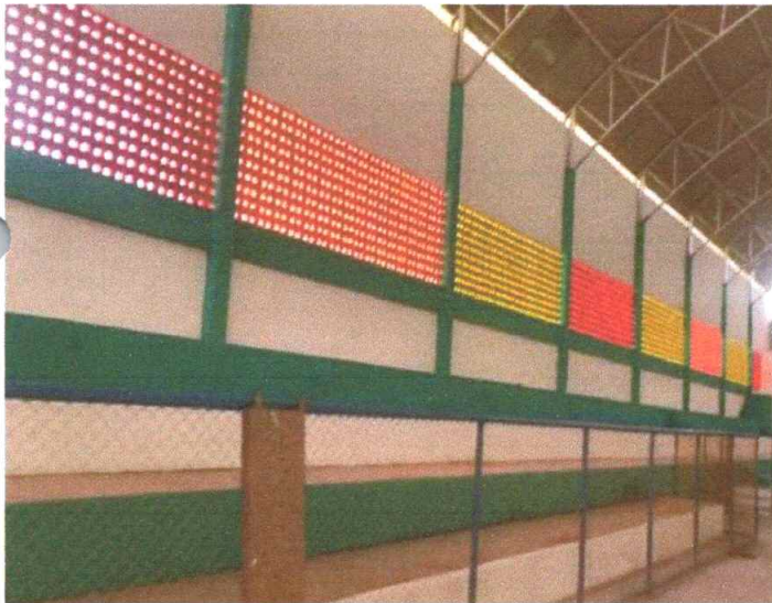
Figura 5 – Pintura de Paredes
