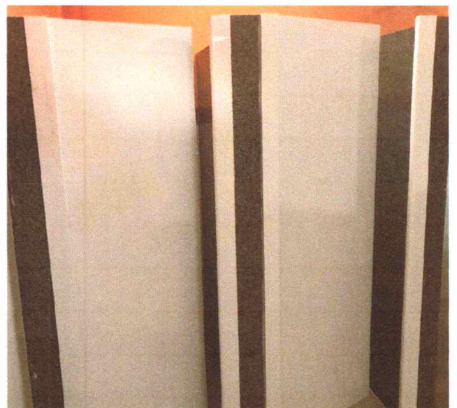
Figura 16 – Portas dos Banheiros
