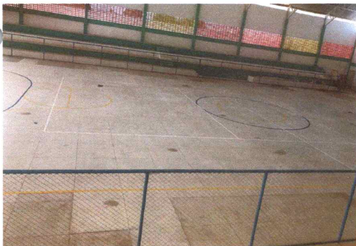
Figura 3 – Demarcação do Piso
