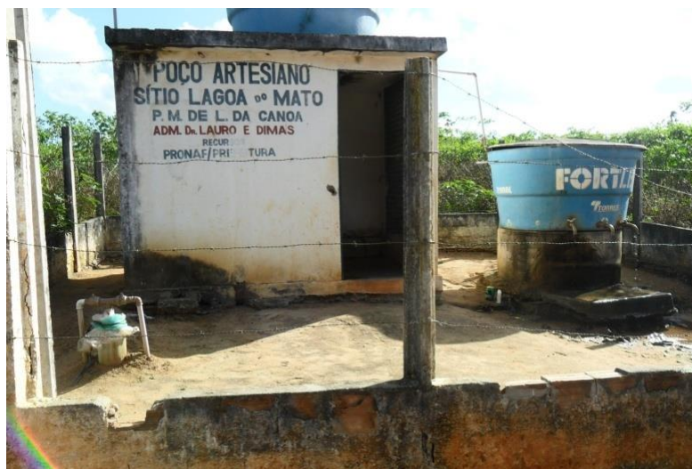
Figura 3: Reservatórios de fibra no Povoado Lagoa do Mato
